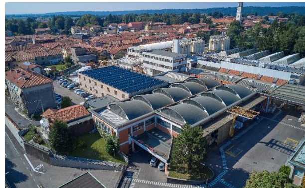
FIGURA 2 - VISTA DALL'ALTO DELLA SEDE DI VEDANO OLONA
